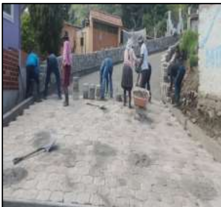
Fotografía 03: Adoquinado en la Comunidad Iltús
