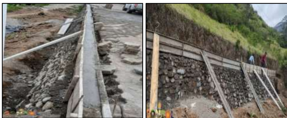
Fotografía 06: Construcción del muro ciclópeo - Proyectos Grupos de Atención Prioritaria
