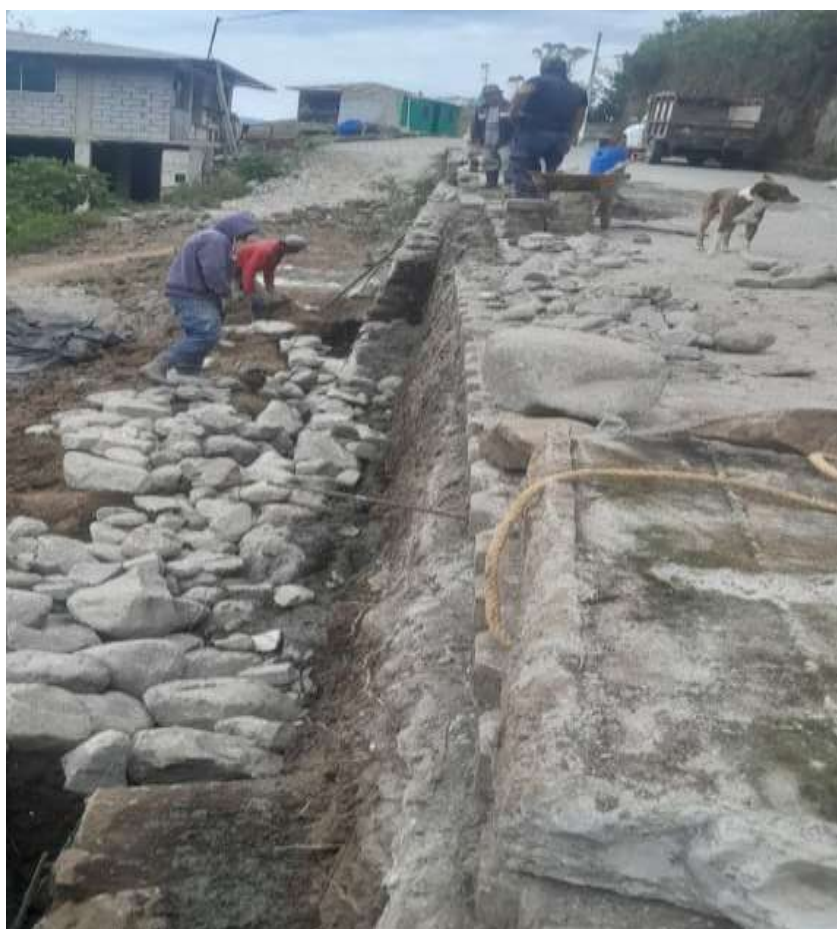
Fotografía 08: Construcción del muro de hormigón ciclópeo en la vía que va a la Comunidad de Cochapamba.
