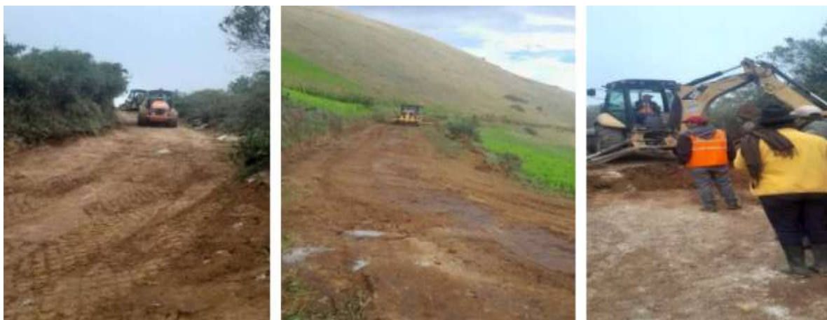
Fotografía 04: Acompañamiento y verificación de los trabajos ejecutados por la Maquinaria del Consejo Provincial en el ensanchamiento y mantenimiento de los Ramales viales de la parroquia.
